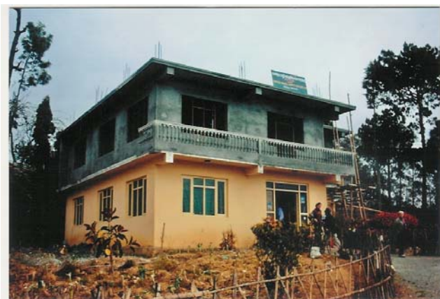
Ziekenhuis (roadside clinic) in aanbouw in Pharping
